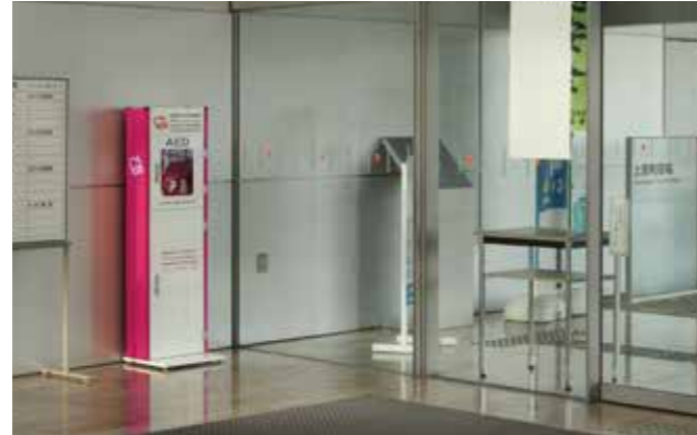
町役場玄関ホール設置例
